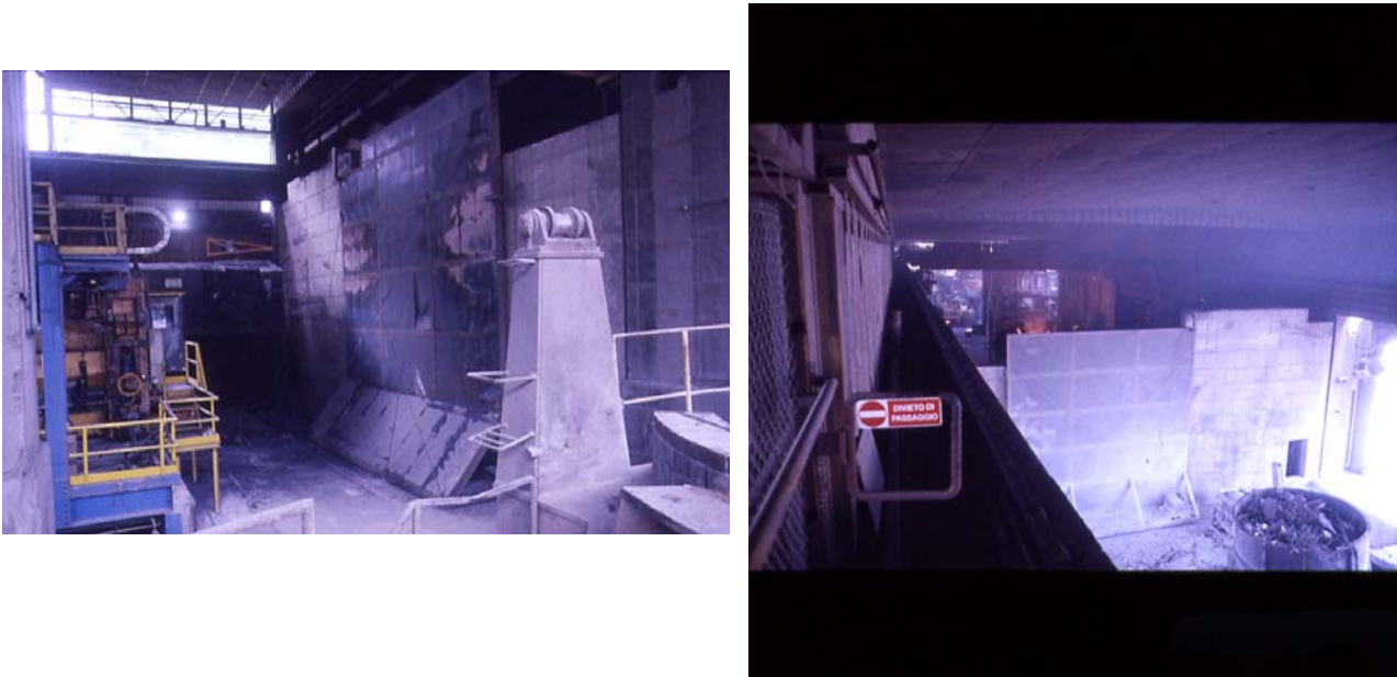
Figura 3.24. Segregazione parziale dell'area forno: viene mantenuta la sezione per il transito del carroponte di carica cesta fra area rottame e area forno; si osserva anche il portellone mobile inserito nella parete Figura 4.25. Vista dall'alto della medesima segregazione
