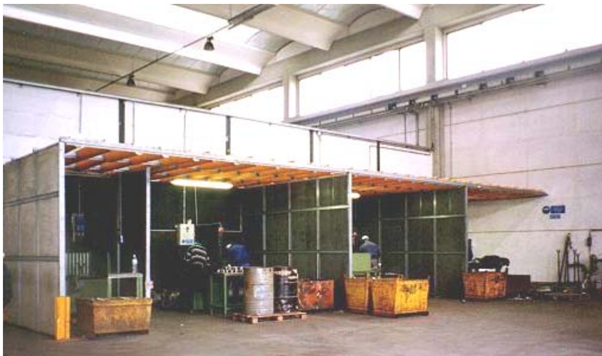
Fig. 3.14.4 Postazioni di lavoro cabinate semichiusate per sbavatura manuale in locale separato da altre lavorazioni.
