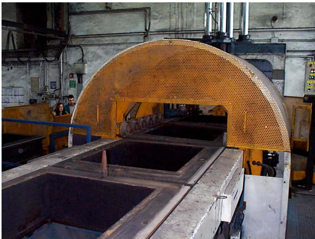
Fig. 3.3.4 Protezione sul sistema di ribaltamento automatico delle staffe sulla linea di formatura automatica.
