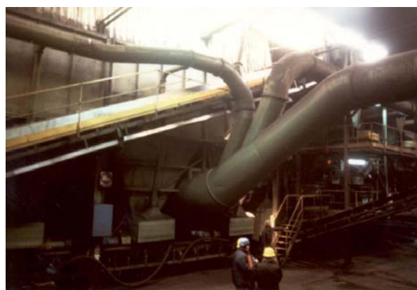
Figura 3.5.2. Impianto preparazione terre. Condotti di aspirazione dei nastri di raccolta e trattamento terre
