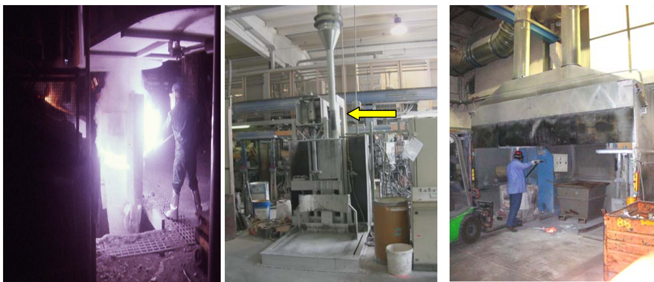
Figura 3.3.11. Trattamento di sferoidizzazione della ghisa con magnesio presidiato con cappa girevole Figura 3.3.12. Postazione di degasaggio. Indicato il sistema di copertura della siviera dotato di tubazione di Aspirazione di fumi e polveri. Figura 3.3.13. Postazione di degasaggio. Affinazione presidiata da cappa
