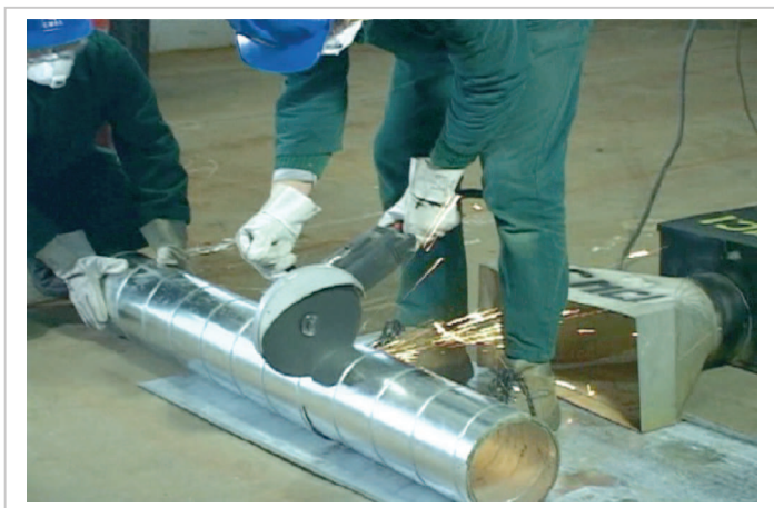
Taglio effettuato con troncatrice con ausilio di aspirazione localizzata
