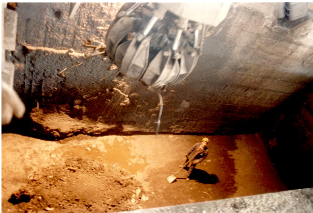
Figura 9. Impresa esterna. Pulizia di una fossa
