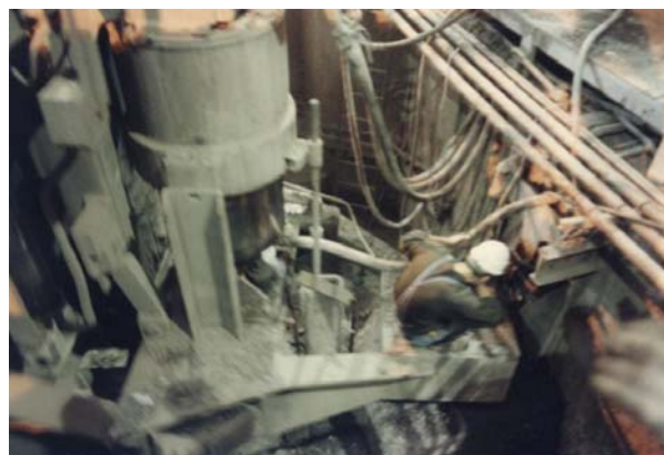
Figura 1. Forno elettrico ad arco. Intervento di manutenzione agevolato dalla presenza di specifica piattaforma Figura 2. Forno elettrico ad arco. Intervento di manutenzione richiesto da perdita dei circuiti di raffreddamento
