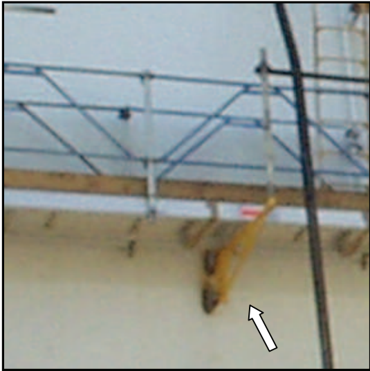
Foto. n. 13 Mensola ancorata alla piastra metallica saldata allo scafo della costruzione navale
