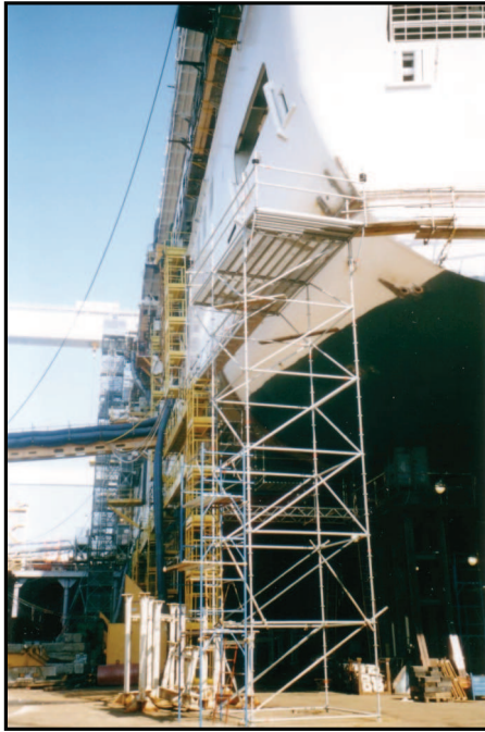
Foto. n.4 Esempio di utilizzo di ponteggi a telai prefabbricati del tipo "multidirezionale" lungo lo scafo della costruzione navale
