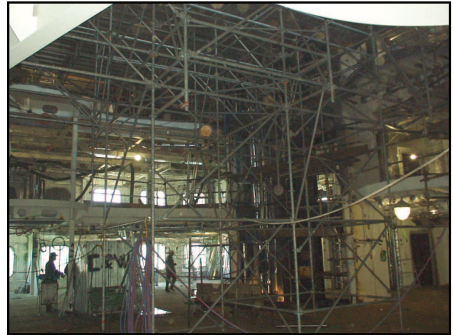
Foto. n.3 Esempio di utilizzo di ponteggi a telai prefabbricati del tipo "multidirezionale" all'interno della costruzione navale
