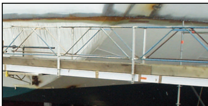
Foto. n. 7 Piano di lavoro
