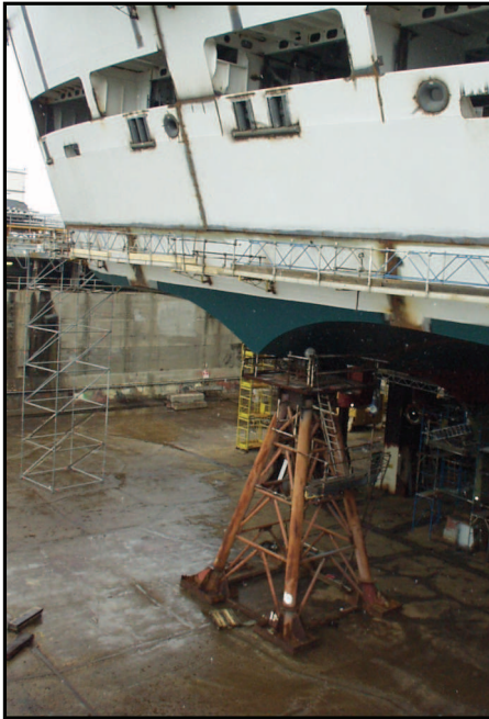
Foto. n. 9 Piano di lavoro installato a poppa della costruzione navale
