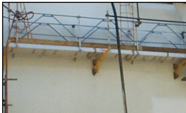
Foto. n. 8 Piani di lavoro installati lungo lo scafo della costruzione navale
