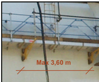
Foto. n. 10 Particolare della distanza tra le mensole
