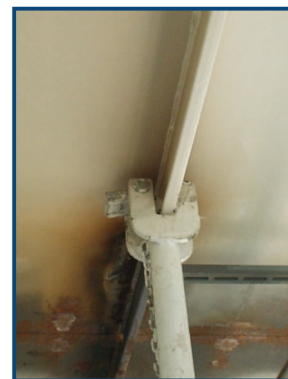
Foto n.6 Particolare di attacco a pipa
