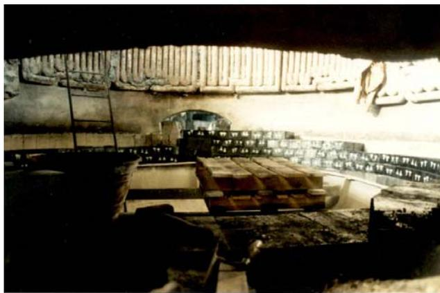
**Figura 3.8.3. Demolizione rivestimento di sicurezza paniera con martello pneumatico**
