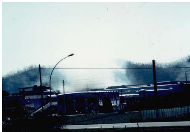
Figura 4.17. Emissioni diffuse in condizioni di criticità del sistema di aspirazione
