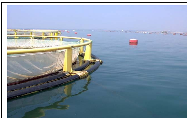
Fig. 9. corsia di servizio
