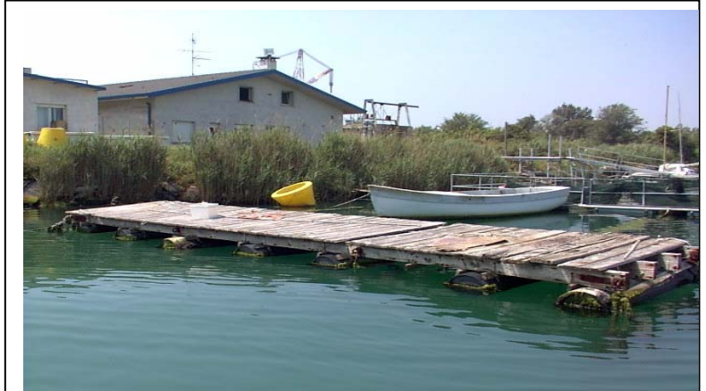
Fig. 17: pontile galleggiante
