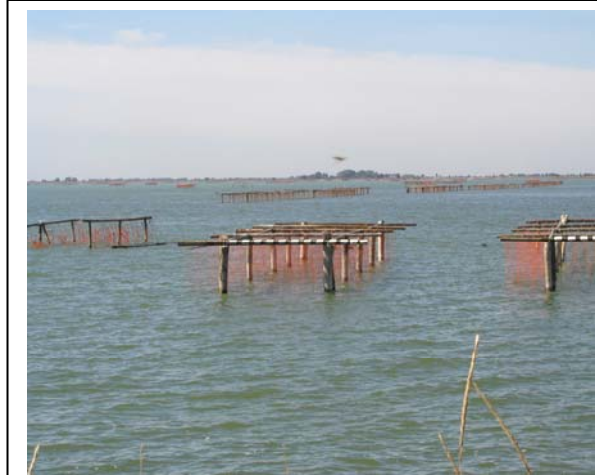
Fig. 4: impianto di mitilicoltura in laguna
