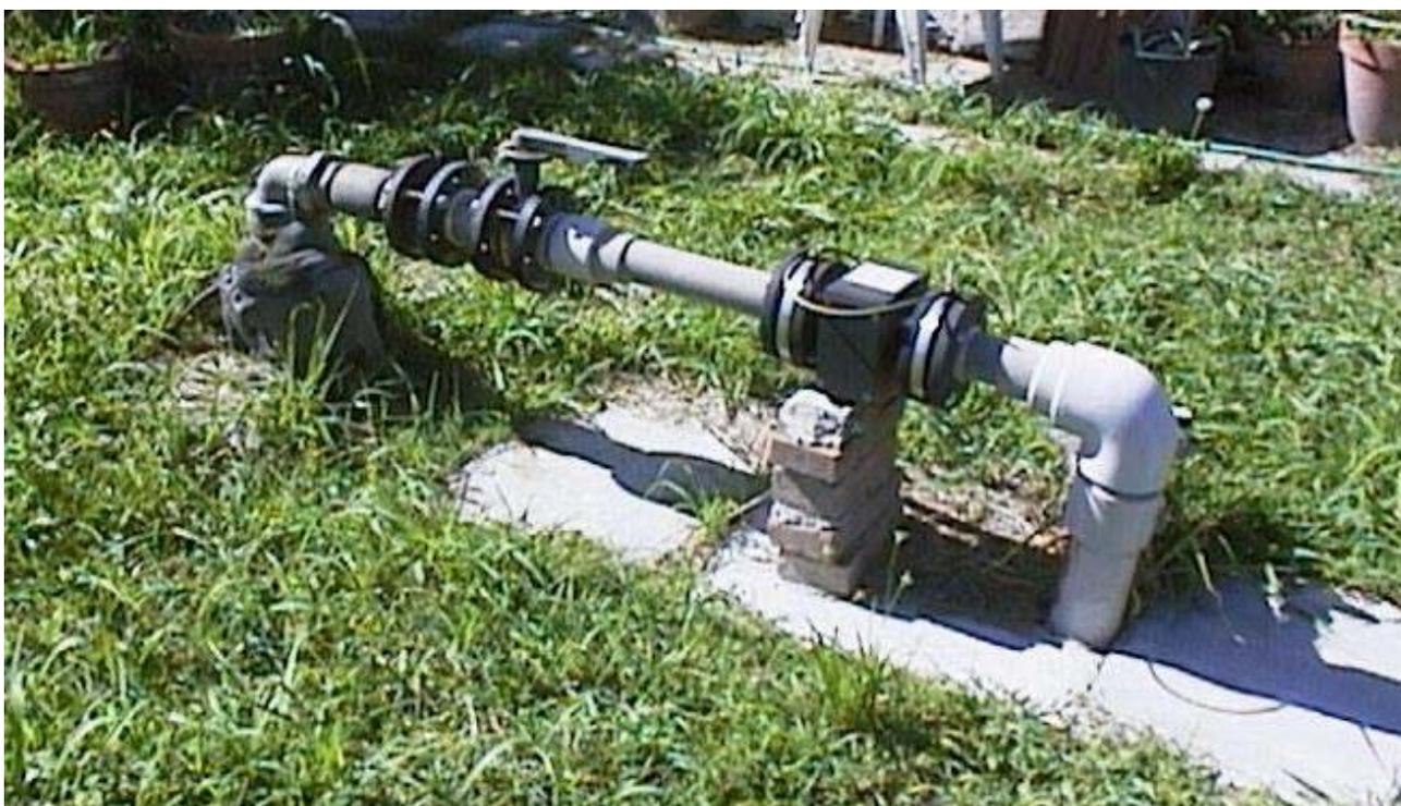
Ecco come si presenta un pozzo termale, sulla sinistra vi è la bocca pozzo, costituita da un tubo in acciaio che si sviluppa in profondità, sullo stesso è inserita una elettropompa ad immersione che provvede a garantire il flusso di fabbisogno di acqua termale necessario per il ciclo produttivo. A destra è visibile, sostenuto dai mattoni, il gruppo di misura dell'acqua estratta.
