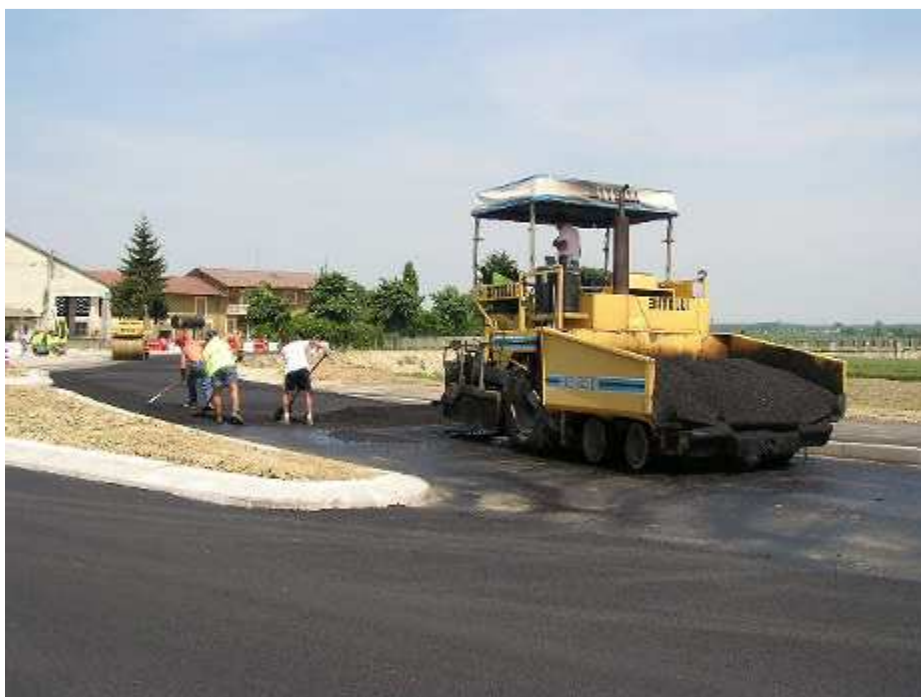
Figura 3-4 – Stesa asfalto con vibrofinitrice.
