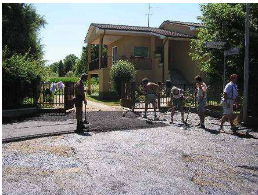
Figura 3-5 – Stesa asfalto manuale.
