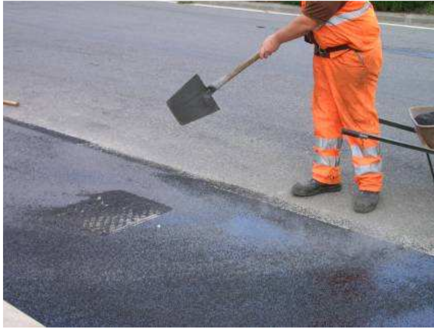
Figura 4-7 – Spargimento di sabbia su marciapiede.
