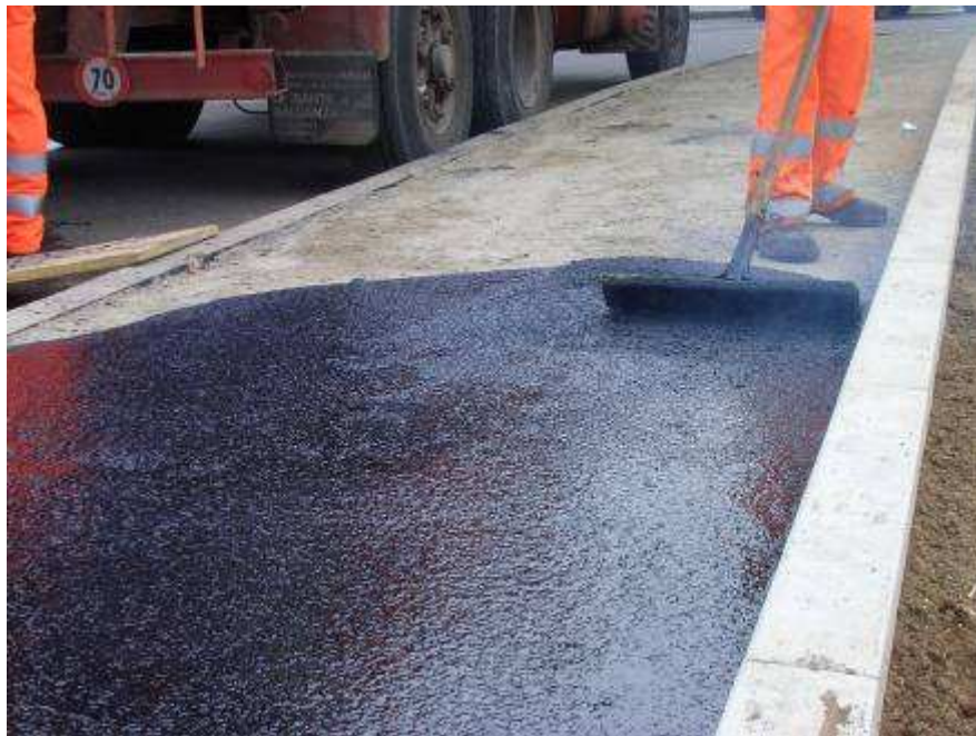
Figura 4-6 – Stesa di asfalto colato su marciapiede.
