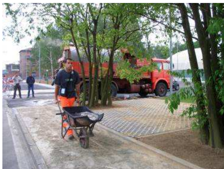
Figura 4-4 - Trasporto di asfalto colato con carriola.
