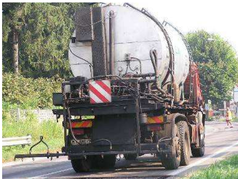
Figura 3-2 – Applicazione emulsione bituminosa automatica.
