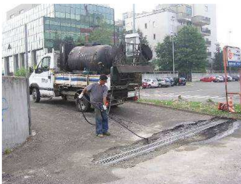
Figura 3-3 – Applicazione emulsione bituminosa manuale.
