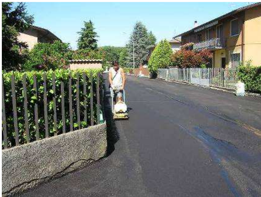
Figura 3-7 – Compattazione asfalto con piastra vibrante.
