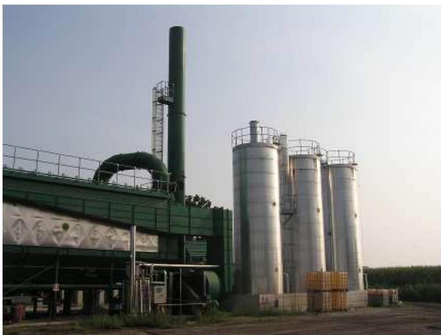
Figura 2-3 – Stoccaggio filler nello stabilimento di produzione.
