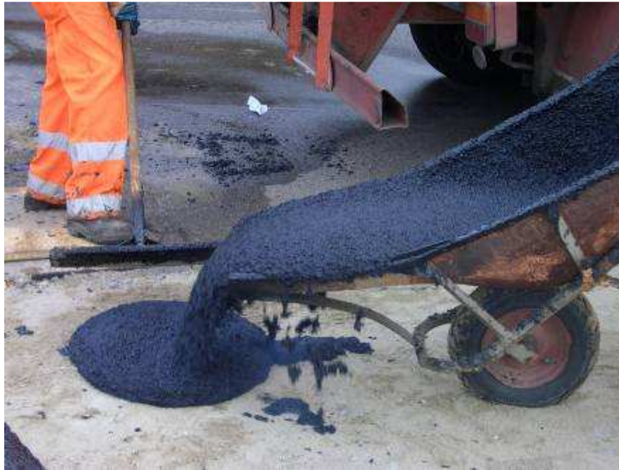
Figura 4-5 – Stesa di asfalto colato su marciapiede.
