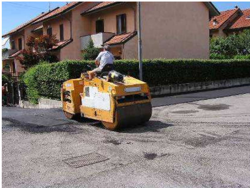
Figura 3-6 – Compattazione asfalto con rullo.
