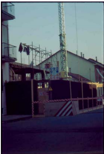
Segnalazioni dell'ingombro della sede stradale e corridoio di transito pedonale
