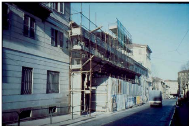
Ponteggio "tubo e giunto"
