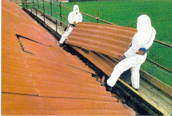
Rimozione lastre in cemento – amianto pretrattate
