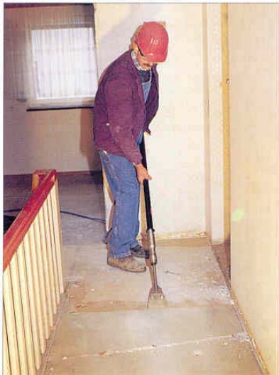
Rimozione pavimentazione con utensile pneumatico
