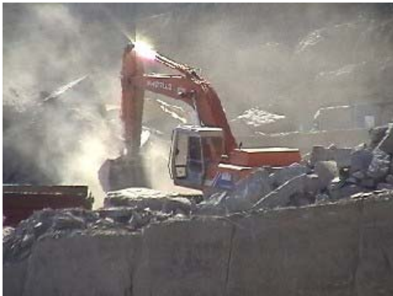
Fig. 05 Movimentazione materiali lapidei mediante escavatore
