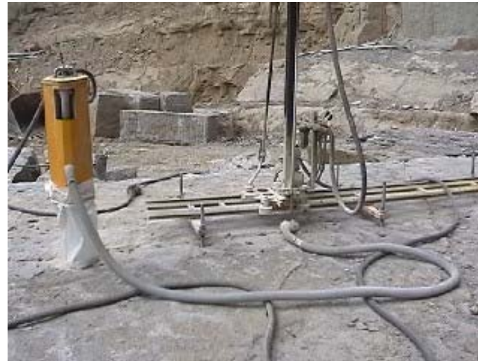
Fig. 06 Perforazione mediante tagliablocchi
