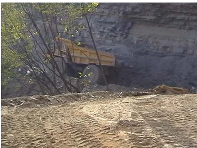
Fig. 41 Allontanamento del materiale di risulta mediante dumper
