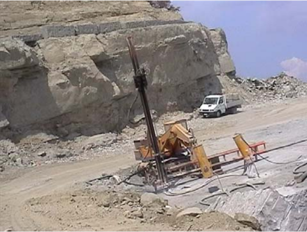
Fig. 84 Tagliablocchi installato sul braccio di un escavatore cingolato
