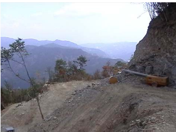
Fig. 36 Rimozione del terreno vegetale, con inizio della successiva fase di scoperchiatura
