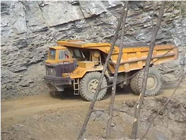
Fig. 23 L'allontanamento del materiale di risulta mediante dumper su strada sterrata
