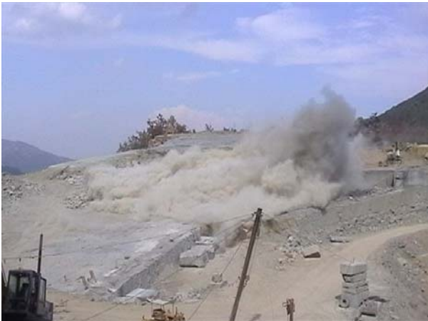
Fig. 53 Allontanamento degli strati superficiali di arenaria e galestro mediante esplosivo (volata)
