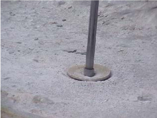
Fig. 83 Uso del martello pneumatico munito di cappuccio copriforo
