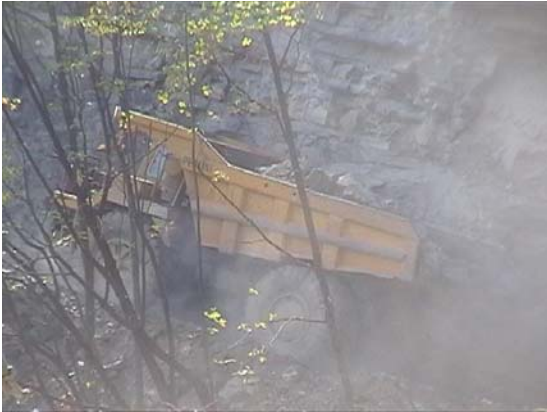
Fig. 19 Trasporto del materiale di risulta mediante dumper ed evidente polverosità durante tale attività
