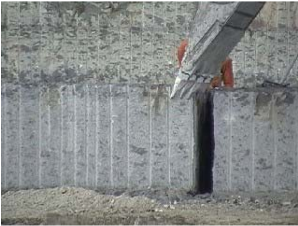
Fig. 90 Spostamento del blocco con la benna dell'escavatore
