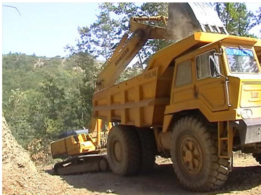
Fig. 40 Caricamento del materiale di risulta su dumper mediante escavatore
