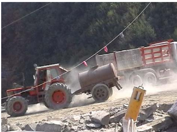
Fig. 08 Bagnatura del piazzale di cava
