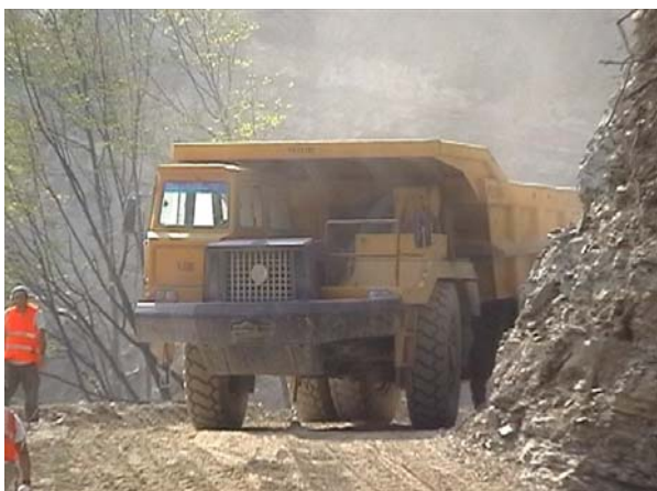
Fig. 22 Un dumper impiegato per l'allontanamento del materiale di risulta durante la costruzione della viabilità di cava.
