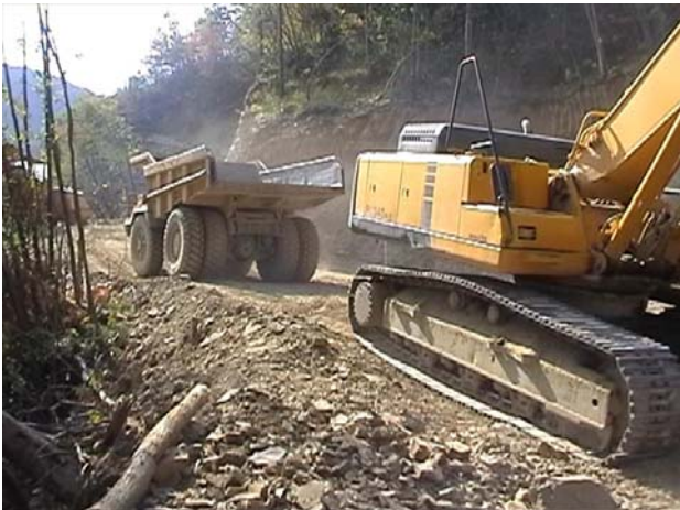
Fig. 39 Caricamento mediante escavatore del materiale di risulta su dumper
