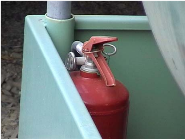
Figg. 64 e 65 Deposito olii: estintore e collegamento a terra
