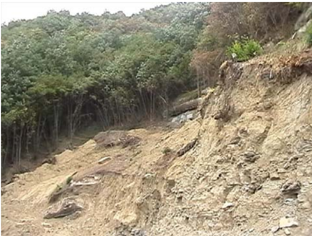
Fig. 35 Rimozione terreno vegetale
