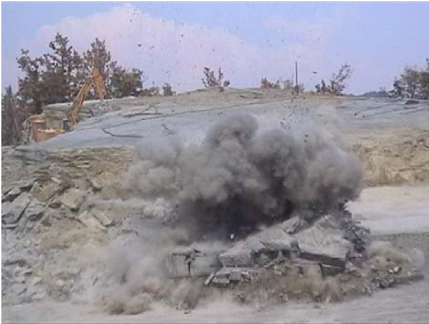
Fig. 54 Allontanamento degli strati superficiali di arenaria e galestro mediante esplosivo (volata)
