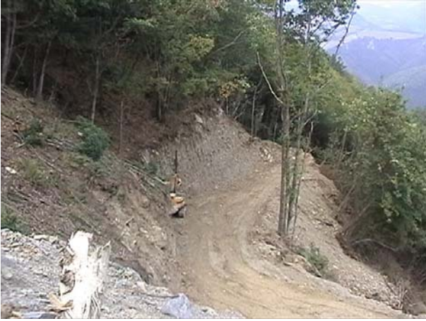
Fig. 20 Strada di arroccamento in fase di realizzazione
