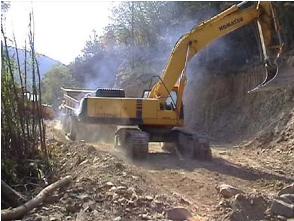
Fig. 25 Il caricamento del materiale di risulta con presenza di gas di scappamento proveniente dall'escavatore e dal dumper
