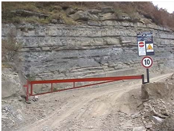
Fig. 28 Barriera mobile a bandiera e specifica cartellonistica di cava contenente la segnaletica di divieto / pericolo, gli estremi autorizzativi e le figure responsabili di cava
