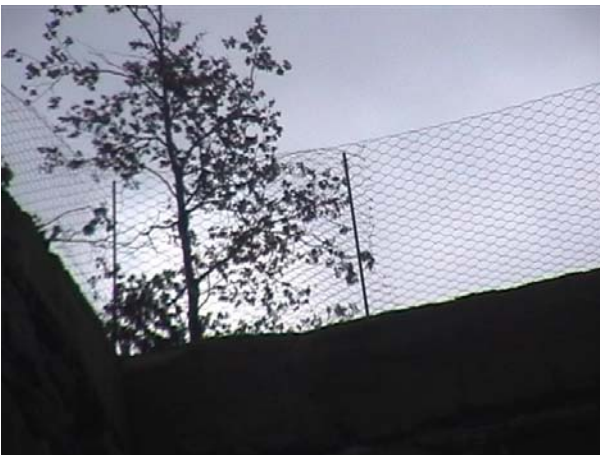
Fig. 33 Recinzione di cava.
