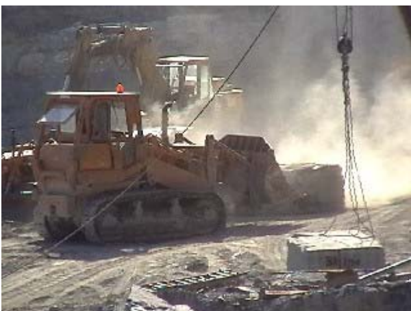
Fig. 92 Spostamento del blocco mediante pala meccanica cingolata
