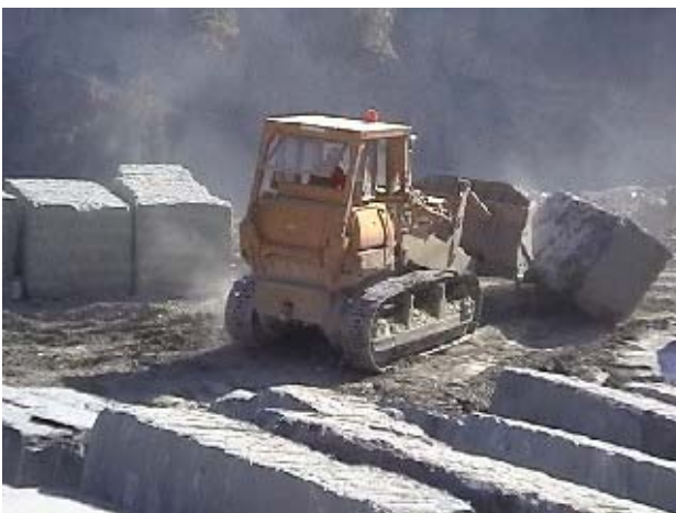
Fig. 91 Spostamento del blocco mediante pala meccanica cingolata
