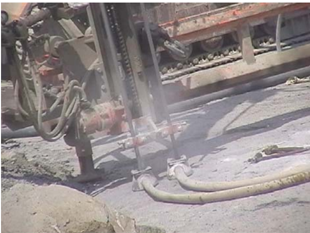
Fig. 81 Perforazione con tagliablocchi munita di aspirazione localizzata
