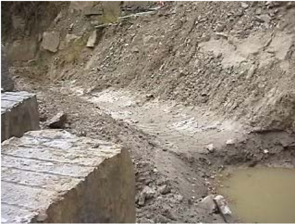
Fig. 50 Vasca di decantazione e fosso di raccolta e di guardia delle acque meteoriche, con argine a blocchiera
