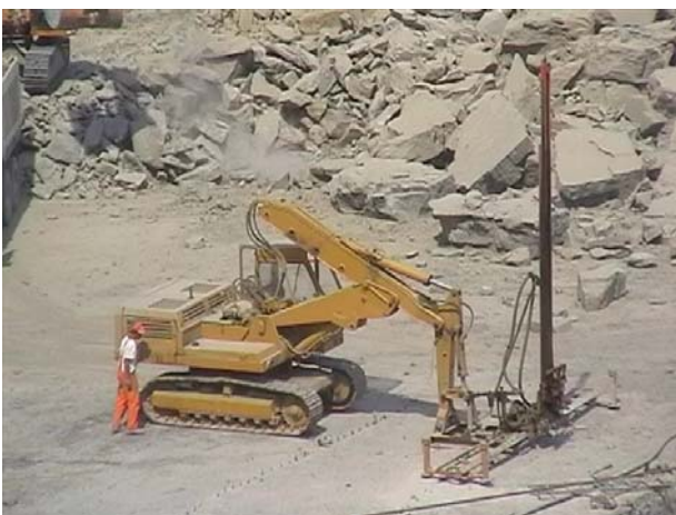
Fig. 67 Tagliablocchi installato sul braccio di un escavatore cingolato
