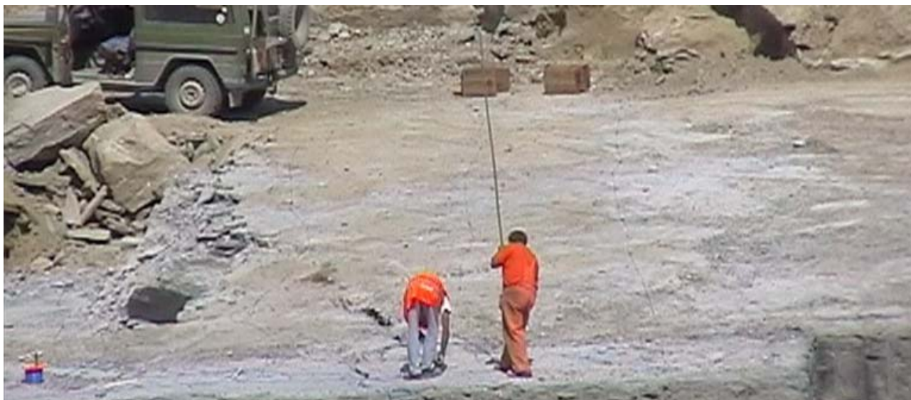
Fig. 72 Caricamento della volata
