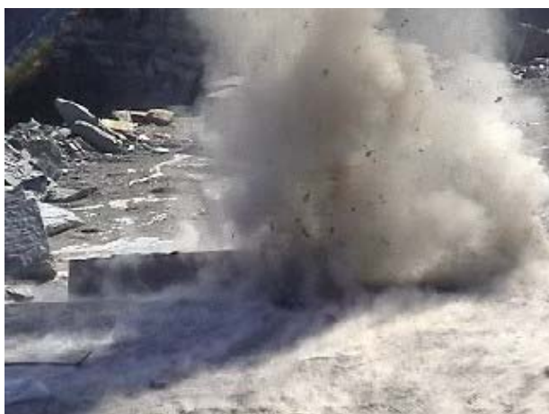
Fig. 52 Allontanamento degli strati superficiali di arenaria e galestro mediante esplosivo (volata)
