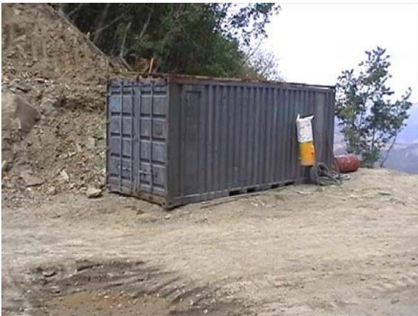
Fig. 62 Container deposito attrezzature varie
