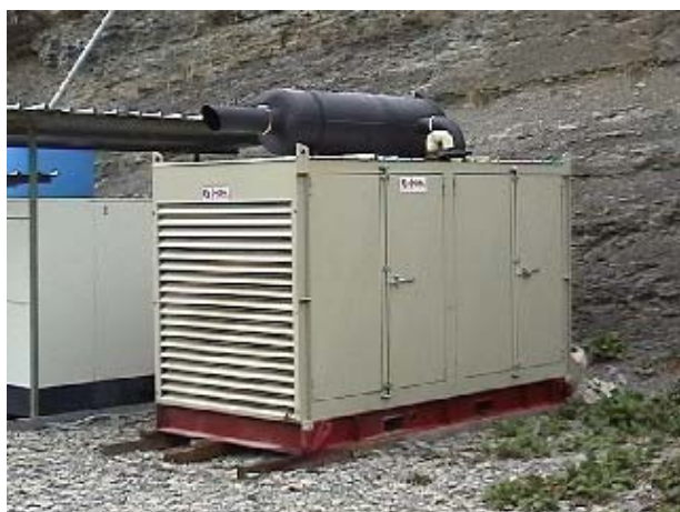
Fig. 58 Gruppo elettrogeno insonorizzato a gasolio
