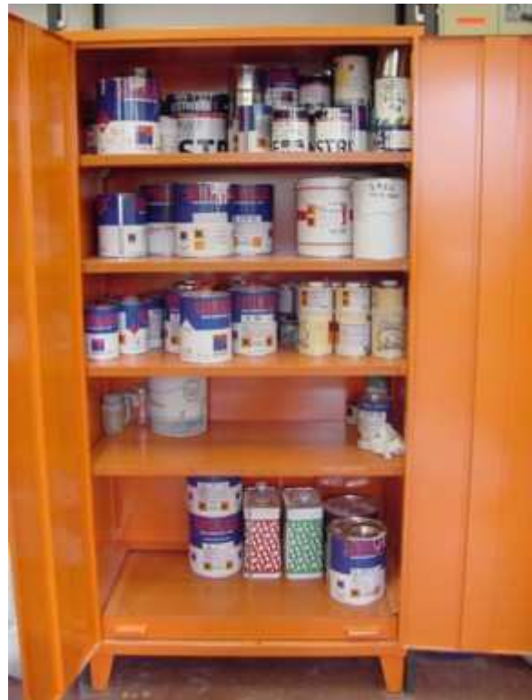
Foto n. 21 - particolare dell' interno dell'armadio di cui alla foto n. 20. I ripiani sono costituiti da grigliato ed il fondo è dotato di cassetto per contenere gli eventuali sversamenti accidentali.
