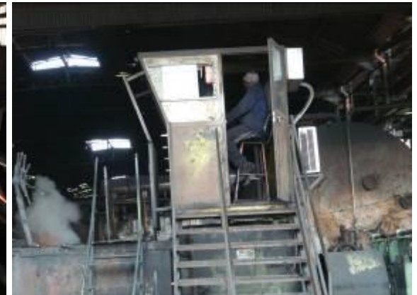
CAPO MACCHINA CABINA DI CONTROLLO
