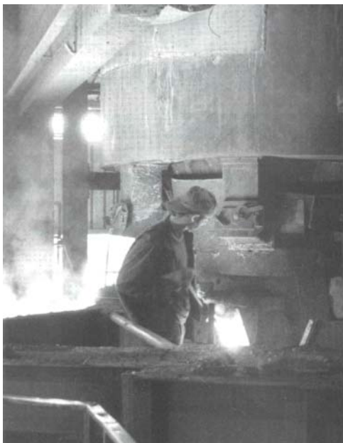
Spillaggio di ghisa da forno a cubilotto con siviera sostenuta da carrello
