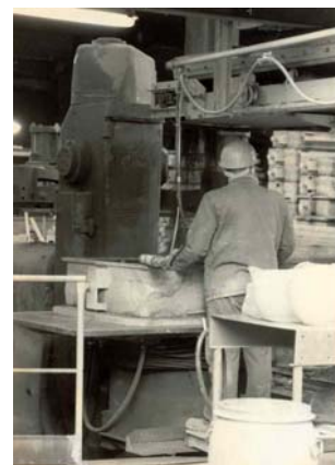
Figura 3.6.5. Formatura a macchina per vibroscossa Figura 3.6.6. Formatura a macchina per vibroscossa. Caduta di polveri da nastri sulle posizioni di lavoro
