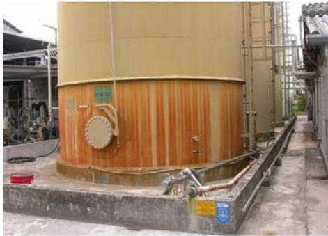
contenere prodotti infiammabili, possono essere dotati di "vent", rompifiamma e sistema di raffreddamento a pioggia, con controllo continuo della temperatura.
