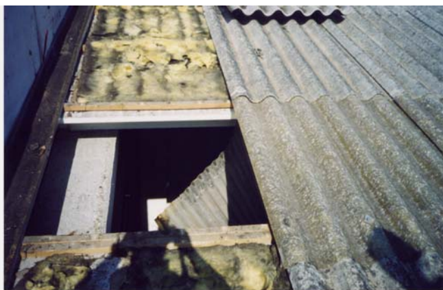
Esempi di lastre in polycarbonato e cemento-amianto rotte a causa del peso dell'operatore in occasione di interventi di manutenzione
