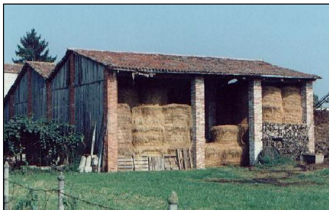
Deposito per foraggio realizzato mediante riconversione di vecchia struttura
