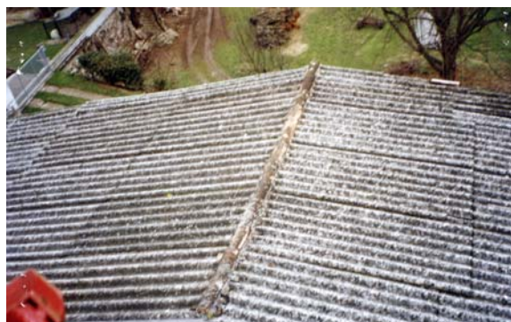
Strutture agricole con coperture costituite da lastre in cemento-amianto
