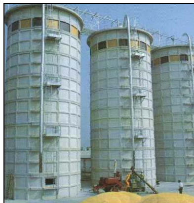
Silo verticale prefabbricato
