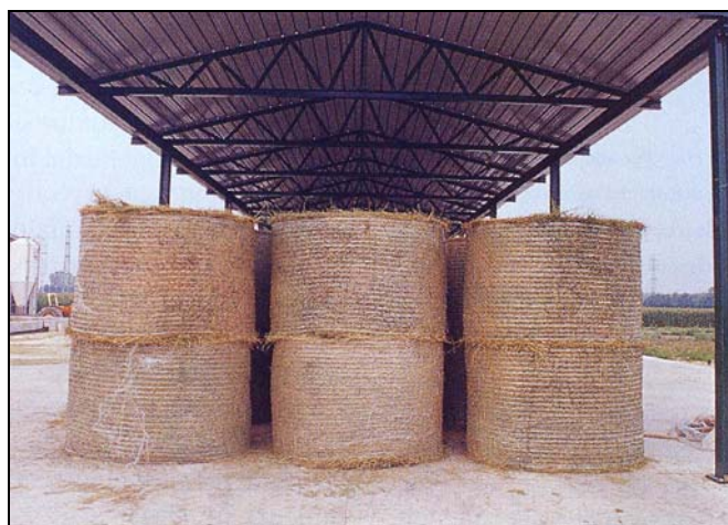
Deposito di fieno costituito da semplice tettoia
