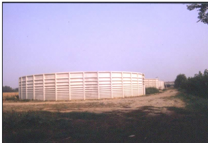
Vasca di stoccaggio realizzata con elementi prefabbricati
