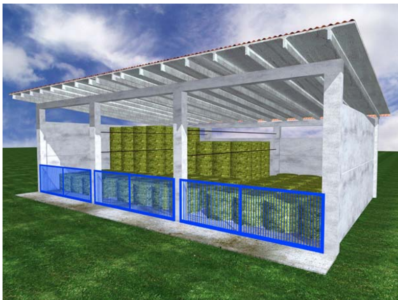
Deposito di rotoballe con segregazione dell'area e dispositivi di contenimento
