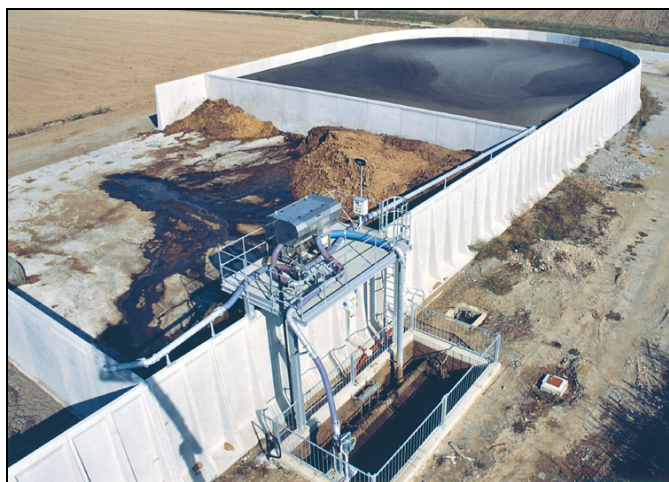
Platea di stoccaggio dei reflui solidi realizzata vicino alla vasca di stoccaggio dei reflui liquidi.
