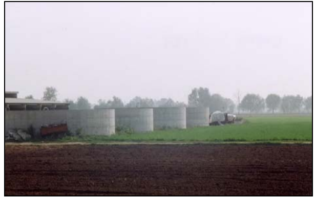
Vasche realizzate in c.a. in opera
