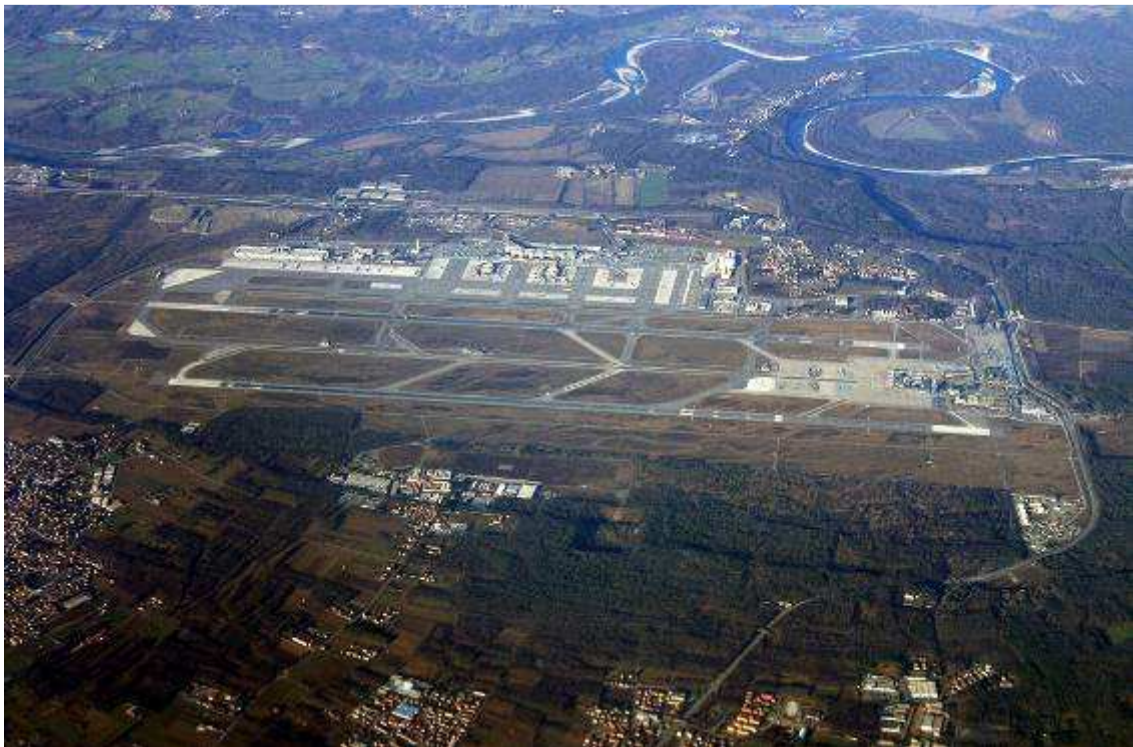
Figura 1-2 – Aeroporto di Milano-Malpensa: panoramica aerea.
